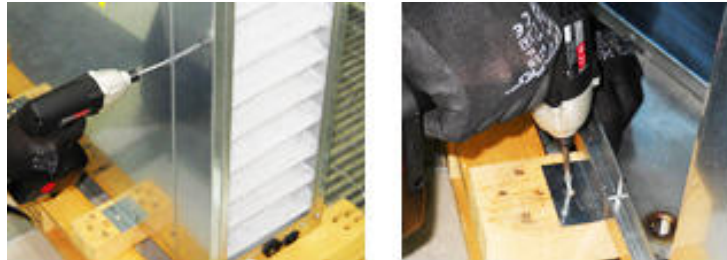
Abb. 1 Entfernen der unteren Tafel und der Schraube des Verankerungsbügel
