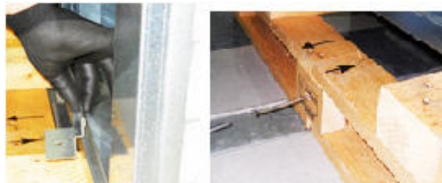
Abb. 2 Entfernen des Verankerungsbügel und der Verbindungsschraube der Palette
